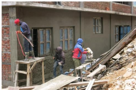
Le bâtiment de 6 classes est presque terminé
