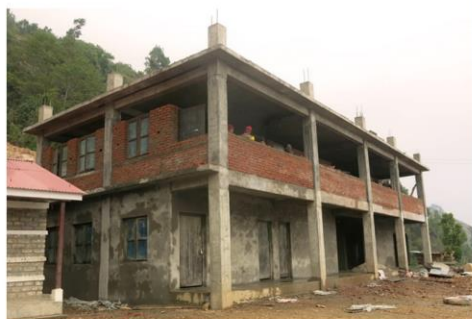
Pose de l'enduit au rez-de-chaussée et montage des murs au 1er étage
