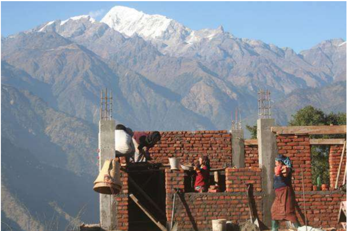
La reconstruction a commencé
